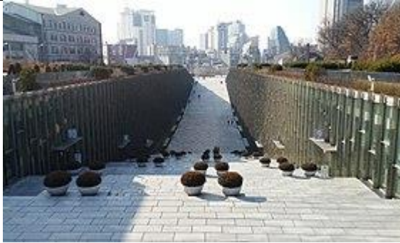
In die Tiefe gebaut Architekt Dominique Perrault
